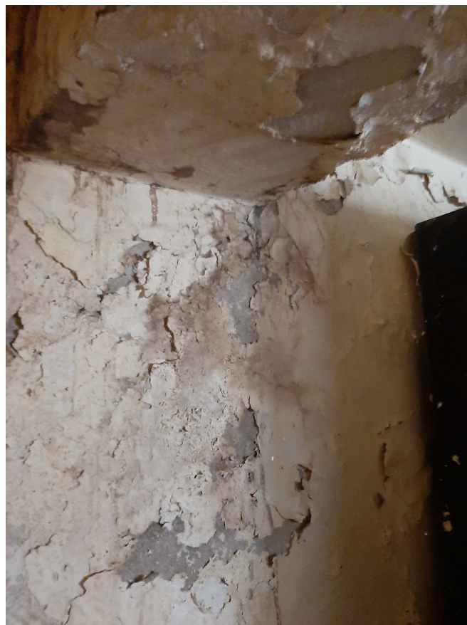
fot. 4. Pleśń i zalanie pom.kantorka – zalanie
